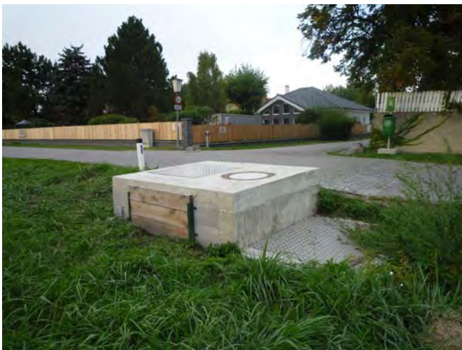
Hochwasserschutzmaßnahme Einlaufschacht Ortsteil bei Mitterndorf
