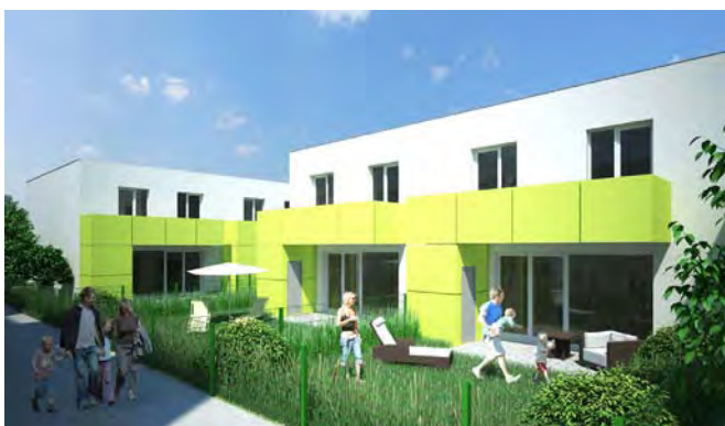
Die Reihenhausanlage Hintere Ortsstraße / Florianiring wird bereits gebaut. (siehe Seite 4)
