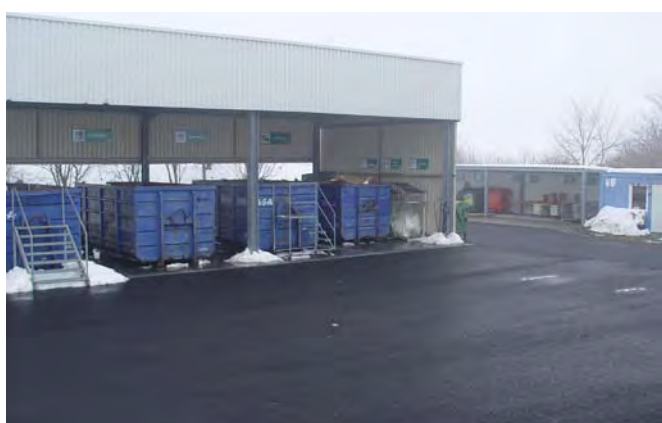
Asphaltierung der Manipulationsfläche unseres Altstoffsammelzentrums am Fuchsenhügel und Ausweitung der Öffnungszeiten im Winter zur weiteren Erhöhung der Benutzerfreundlichkeit.
