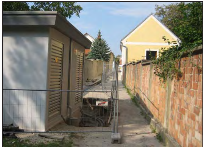
Vorige Woche wurden die Künetten provisorisch geschlossen.
