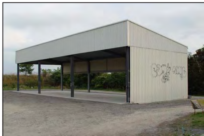
Die Halle des Altstoffsammelzentrums erhielt Betonboden.
