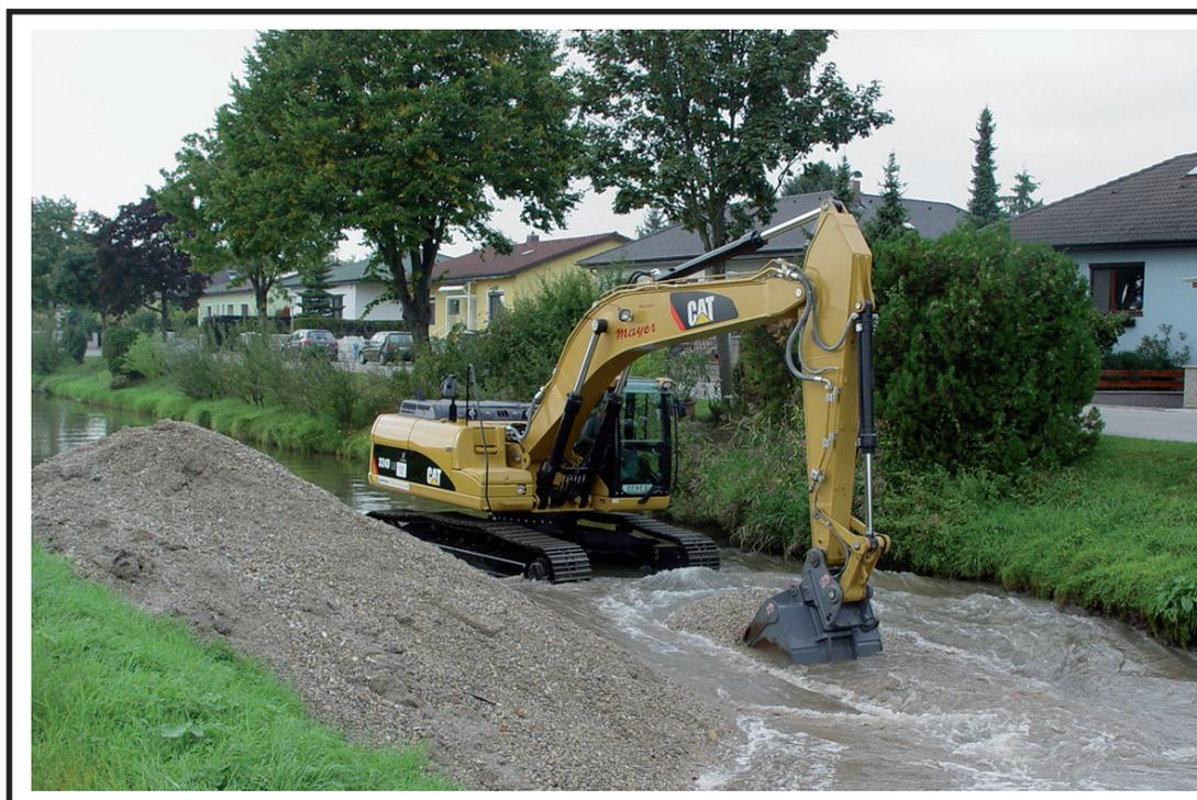
Mitte September erfolgte der Beginn der Neubachsanieierung. Eine Maßnahme, die Aufgrund der nicht zu verhindernden Verlandung des Bachbettes erforderlich wurde. Es wird dabei nicht nur die Bachsohle eingetieft, sondern auch im Zuge der Sanierungsmaßnahmen die Uferböschung schrittweise stabilisiert, um zukünftigen Hochwässern besser entgegenwirken zu können. *(Bericht Seite 5)*
