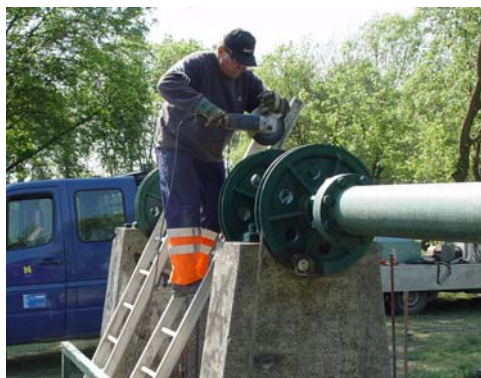
Herbert Horak bei den Reparaturarbeiten
