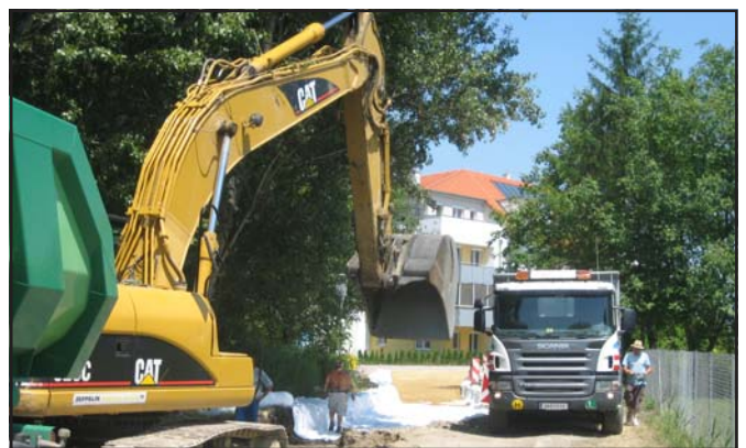
Hier wird zügig gebaut, schon bald gibt es eine schöne Straße
