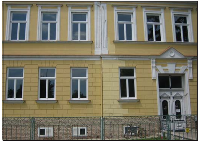
Die neuen Fenster passen hervorragend zum Stil der Fassade
